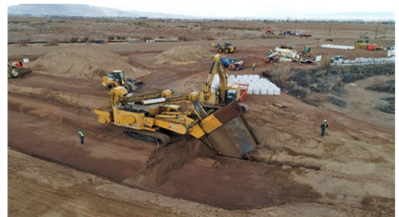
Instalación de Hierro Cero Valente para un estudio de tratabilidad de NERT
